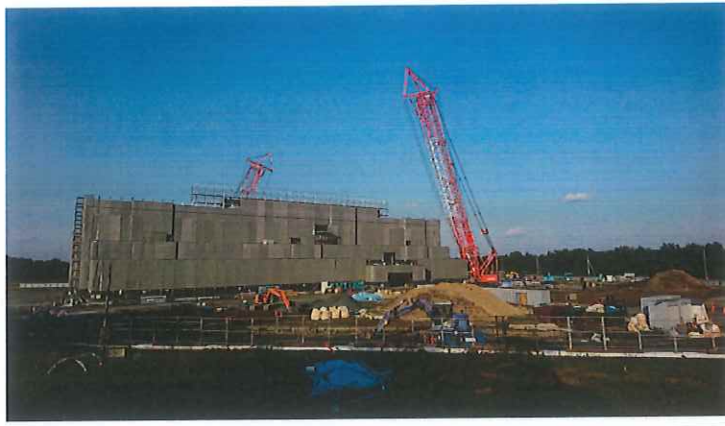
建設が進む西部メディカルセンター
